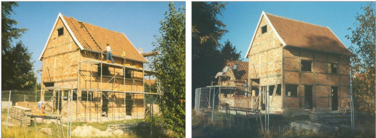
Ausmauern und Dach decken August bis Oktober 1991
